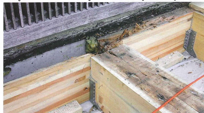
Abb. 2: Terrassenkonstruktion (Baujahr etwa 1998) mit einer PE-Folie als Dampfbremse/Luftdichtung. Schadenursache: kleine Undichtigkeiten bei der Aufbahrung der Abdichtung.
