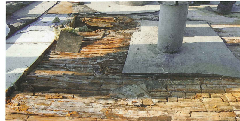
Abb. 3: Vordachkonstruktion (Baujahr etwa 2006) mit bituminöser Dampfbremse. Schadenursache: Aufweichungen infolge Kondensat innen-seitig an den Dunstrohrumfassungen.
