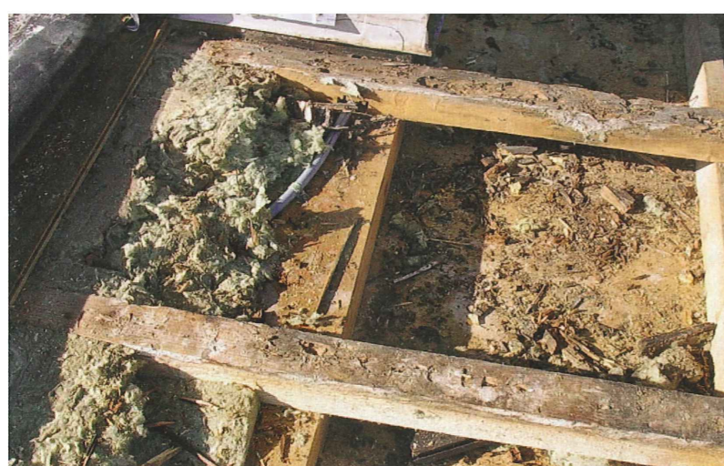
Abb. 1: 1998 erstellte Flachdachkonstruktion mit einer PE-Folie als Dampfbremse/Luftdichtung. Schadenursache: Dampfkongression infolge Luftundichtigkeiten bei Elektrorohrdurchdringungen. Abbildungen: zVg
