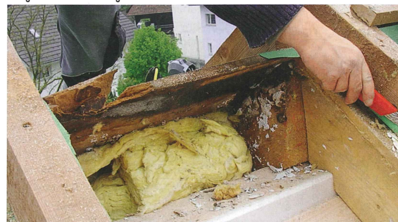
Abb. 4: Fäulniserscheinungen bei MDF-Platte und Sparren bei einem geneigten Dach (Baujahr etwa 2003), Unterdachbahn entgegen den technischen Angaben weitgehend dampfdicht (s-Wert = etwa 20 m), Dampfbremse/Luftdichtung PE-Folie. Schadenursache: Dampfkongression infolge kleiner Luftundichtigkeiten bei Mauerwerksanschlüssen der PE-Folie.
